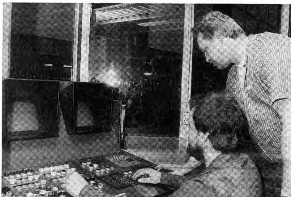
Kontrollzentrum: Alle Funktionen im Griff.
