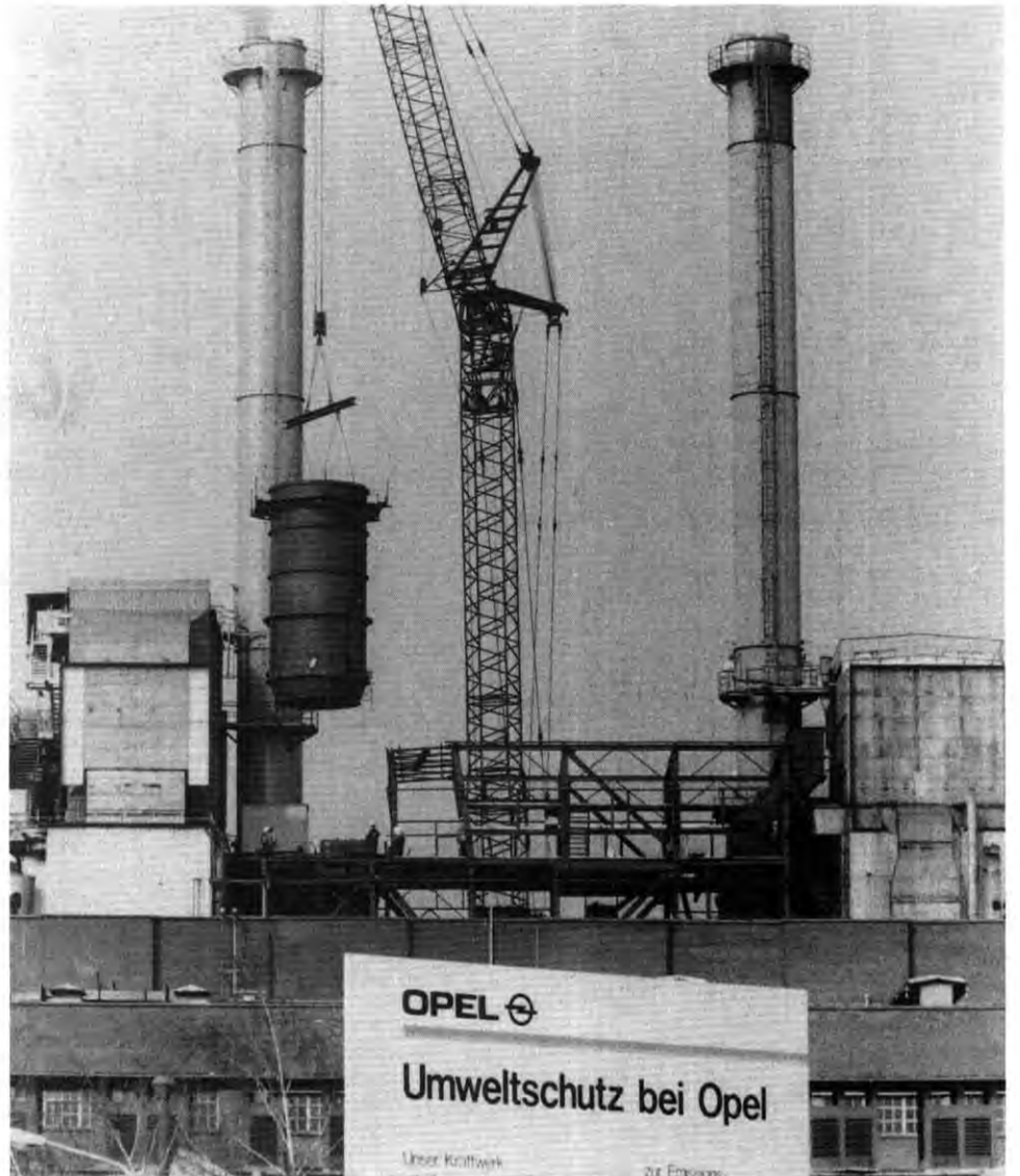
Nachrüstung mit Kran
