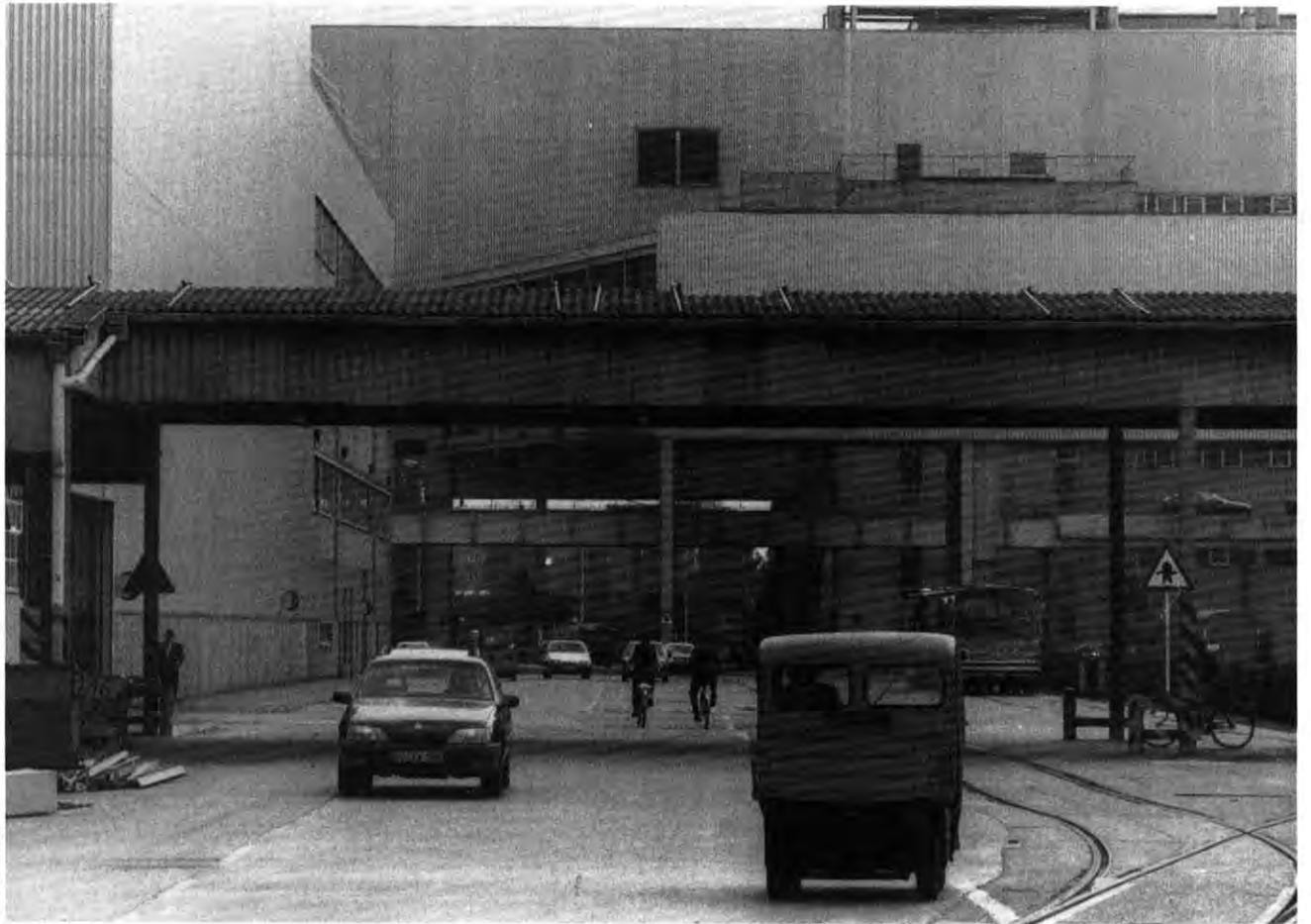
Sanierungs-Objekt: Wie an vielen Stellen wird diese Überdachung bald asbestfrei gemacht
