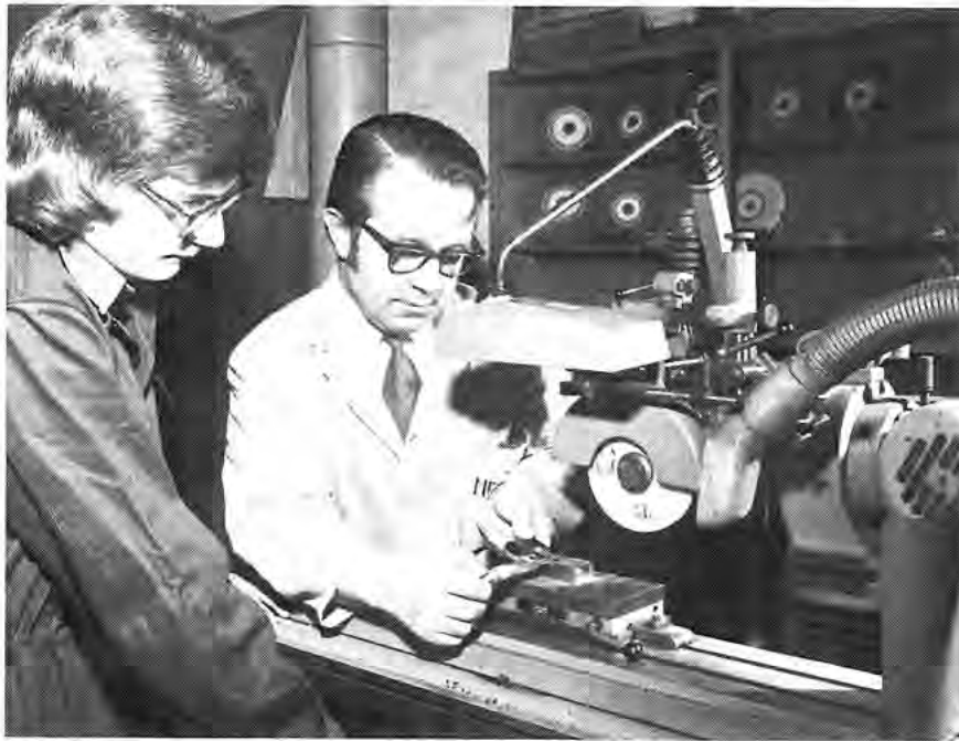
Unterweisung an einer Flachsleifmaschine. Meister M. Schröder überprüft nach der Arbeitsdurchführung die Maßhaltigkeit eines Werkstückes, das der Auszubildende R. Malchert angefertigt hat.
