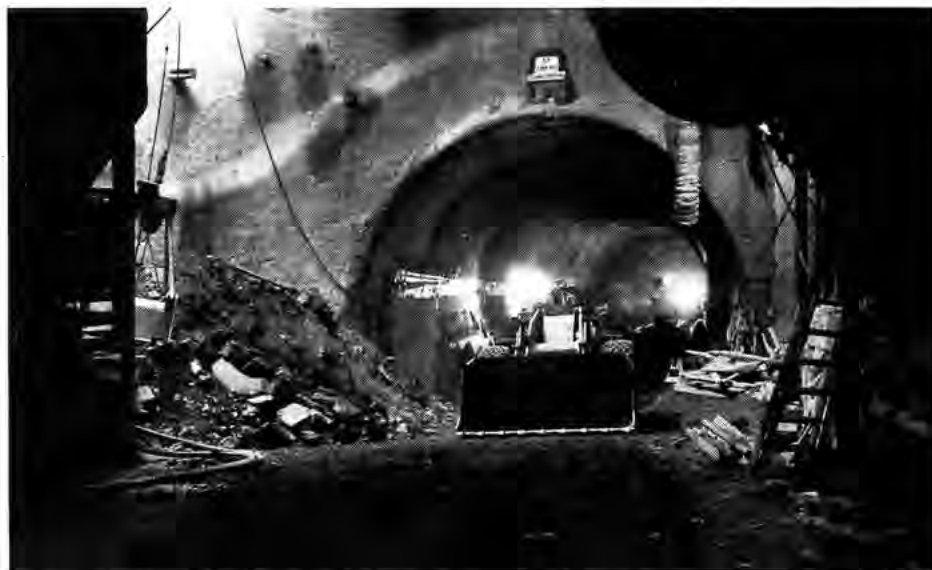
So wird unter der Oberfläche von Bochum gewühlt. Der Tunnelvortrieb für die zukünftige Stadtbahn ist deutlich zu erkennen.
