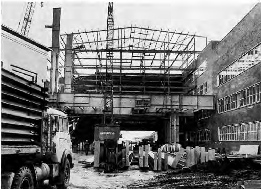
Schnappschuß vom werdenden Neubau K 91 am K 40, in dem nach seiner Fertigstellung fertig lackierte Karosserien vor ihrer Verwendung in der Karosseriefertigmontage gestapelt werden.
