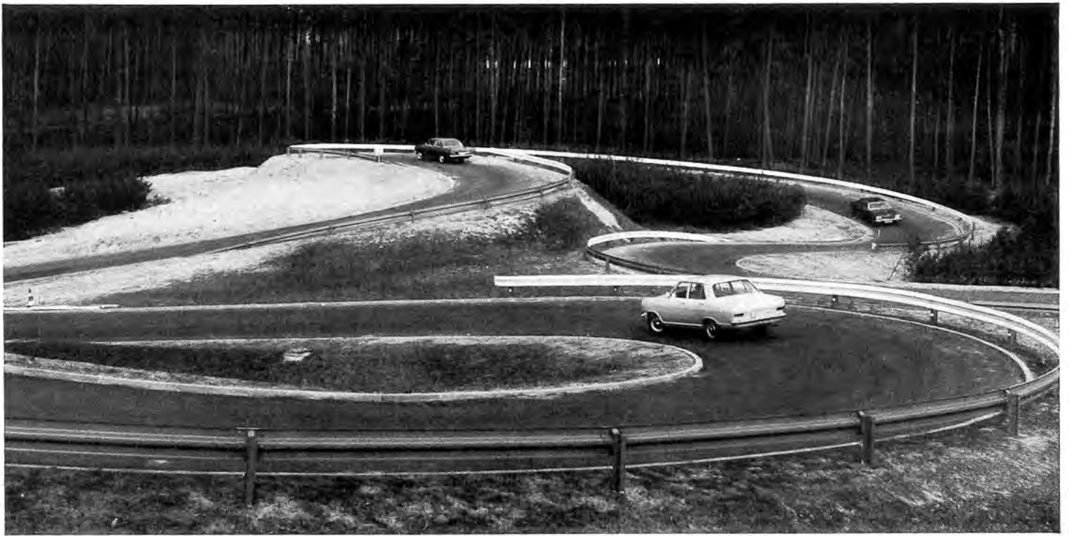
Die Zu- und Abfahrtsstraßen des Berggeländes auf dem Opel-Prüfplatz in Dudenhofen sind wie Paßstraßen mit engen u. engsten Kehren angelegt.
