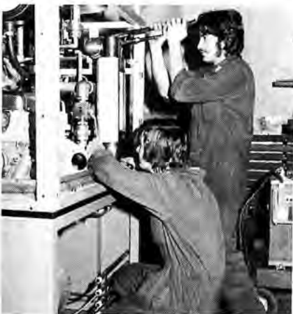
Bei dieser Maschine handelt es sich um eine Wasserpumpen-Prüfvorrichtung. Die Auszubildenden K. Keim (vorn) und K. Kimbel montieren das Flüssigkeitsdurchfluß-Meßgerät.
