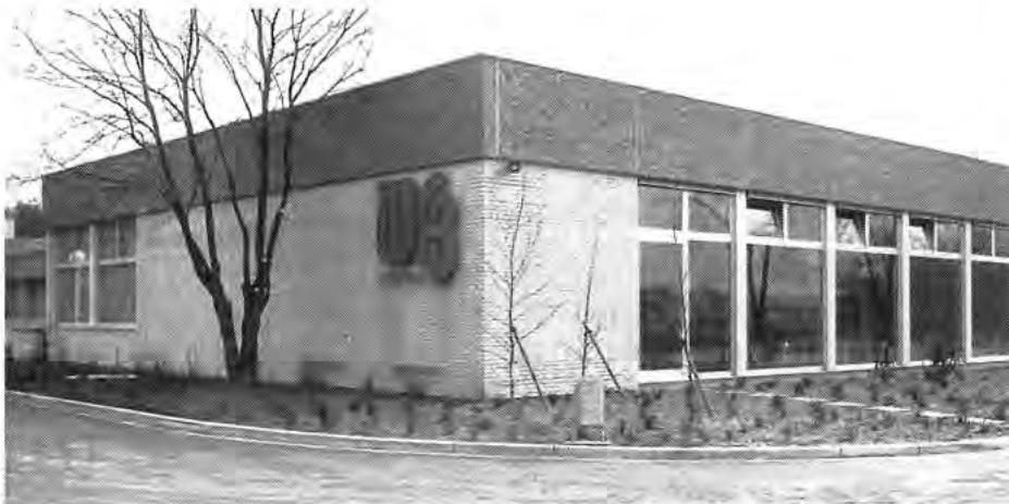
Außenansicht der Werkstätten für Behinderte in Rüsselsheim-Königstädten.
