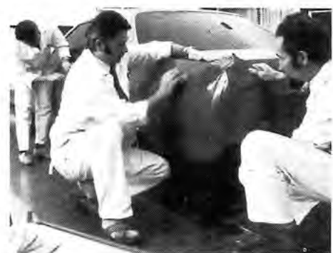
Hier wird die bereits in der Wagenfarbe gespritzte Dinokfolie aufgezogen, um einen Eindruck von der Form zu bekommen. Auf dem Bild die Mitarbeiter H. Spickert, G. Coldewey und A. Schwab.
