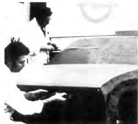
Plastilin wird auf das Modelliergestell aufgetragen. Auf dem Bild die Mitarbeiter G. Coldewey und A. Schwab.
