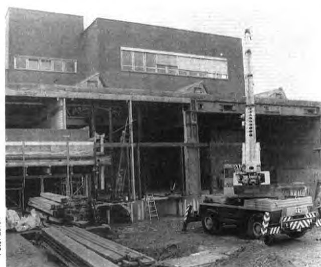
Baustelle: Teile und Zubehör bekommt mehr Platz
