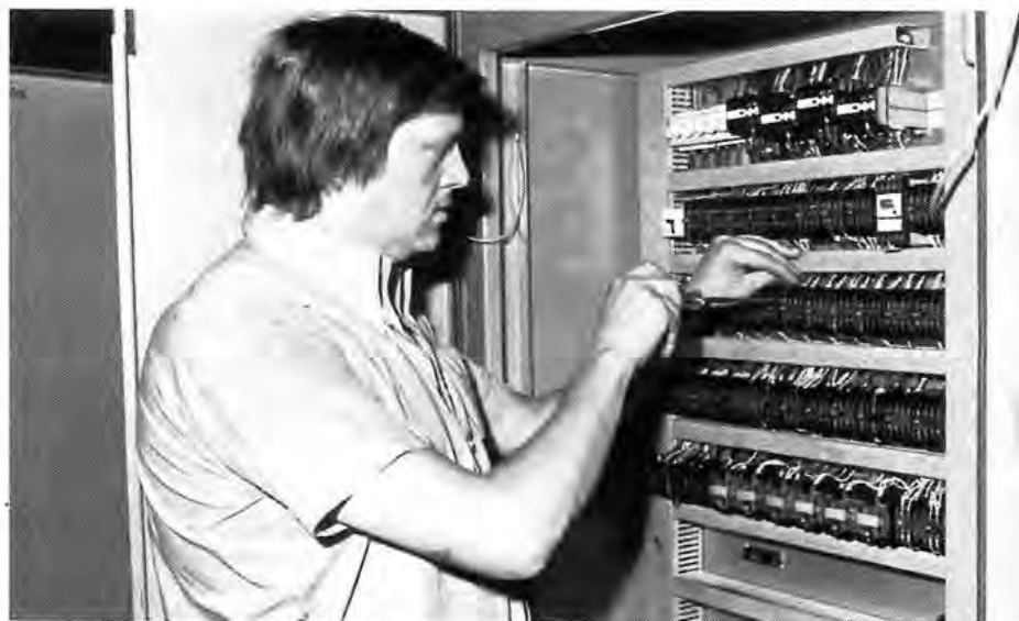
Die Elektro-, Steuer- und Überwachungsgeräte der Pressenstraße befinden sich in zwei Schaltschrankreihen mit insgesamt 85 Meter Länge. An einem dieser Schaltschränke Mitarbeiter H. Kleinhenz.
