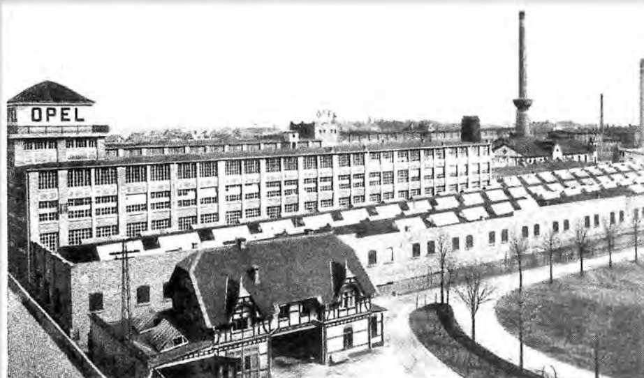
Teilansicht von Südwesten. Vorn das Garagenhaus und ein Stück der ovalen Einfahrbahn. Im Gebäude dahinter befindet sich die Automobil-Endmontage.
