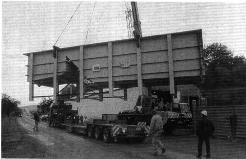
Schwertransport: So kam das Lackier-Tauchbecken nach Eisenach
