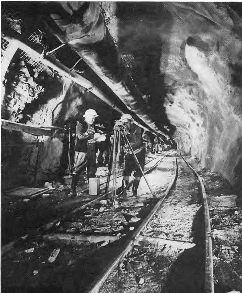
Vermessungsarbeiten im Felbertauerntunnel
