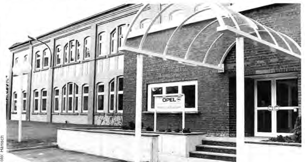
Schmuckstück: Renoviertes Gebäude D 8 in Bochum
