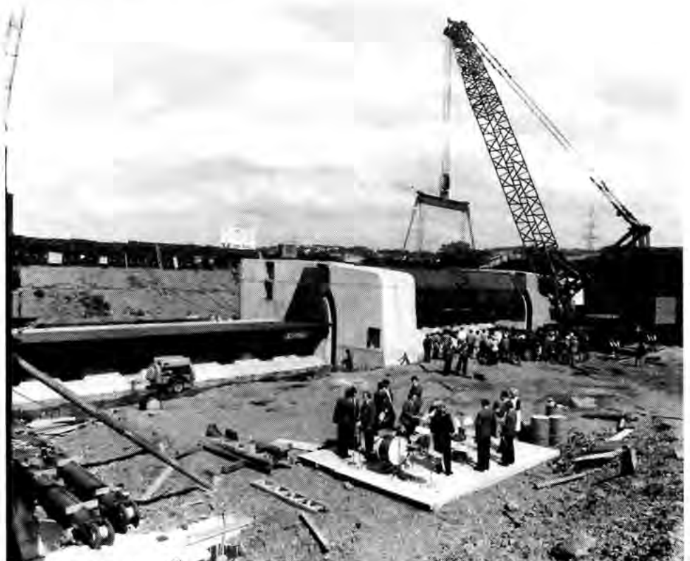
Das Wehr des Kemnader Stausees entsteht. Beim Einsetzen der Stauklappen wurde kürzlich ein kleines „Richtfest“ mit zahlreicher Prominenz gefeiert.
