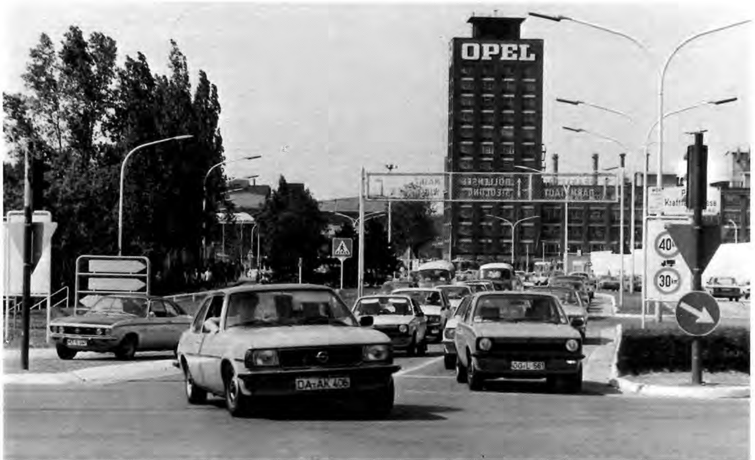
Ein vor und nach jeder Schicht stark frequentierter Verkehrsknoten ist der Ampelbereich zwischen PEK und altem Prufffeld. Zu dem Opel-Berufsverkehr kommt hier noch der Durchgangsverkehr auf der B 43. Vorsicht und Rücksichtnahme auf die von allen Seiten ein- und ausfahrenden Verkehrsteilnehmer ist hier besonders geboten. Auf dem Bild abfließender Verkehr nach der Frühschicht in Richtung Mainz-Wiesbaden, Böllenseesiedlung, Kurt-Schumacher-Ring und Groß-Gerau – Darmstadt.
