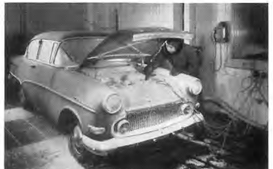
GRÖNLAND IN RUSSELSEIM , Mitarbeiter E. Schaub bei Kaltstartversuchen in der Kältekammer
