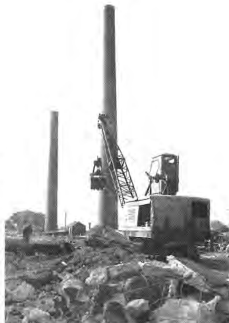
Abbrucharbeiten der Kokerei 1960.
