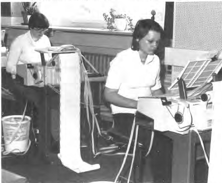
Mitarbeiter Jürgen Gottwald bei Verdrahtungsarbeiten am Hauptverteiler in der Telefonzentrale (oben links). – Prüfarbeiten an der Datenregistrieranlage mit Meister Reinhold Wenchel (oben rechts). – Die Auszubildende Christine Engelhard (vorn) und Mitarbeiterin Angelica Huarte beim Absetzen von deutschen und fremdsprachlichen Fernschreiben über das öffentliche Telex-Netz in der Fernschreibzentrale.
