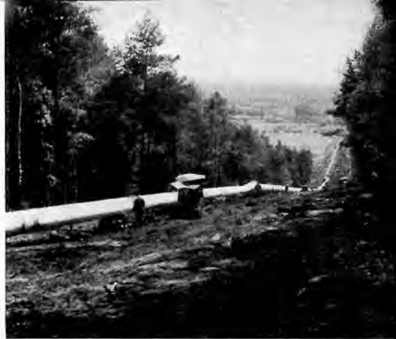
ÜBER EIN JAHR benötigten 10 Baukolonnen, um die 390 km lange „stählerne Schlange“ vom Meer zum Rhein zu verlegen
