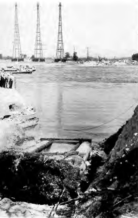
EINE IMPOSANTE technische Leistung: Die „Unterdükerung“ des Rheins bei Leverkusen. Der Schiffsverkehr lief während der komplizierten Rohrverlegung ungestört weiter
