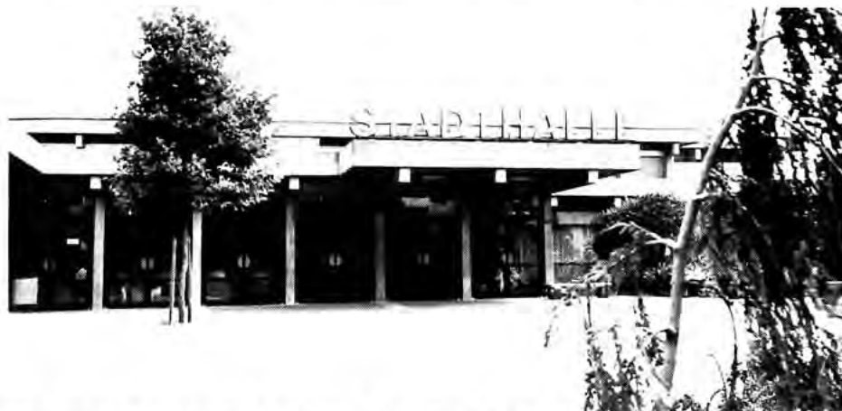
Die moderne Stadthalle in Flörsheim, Schauplatz vieler Veranstaltungen.
