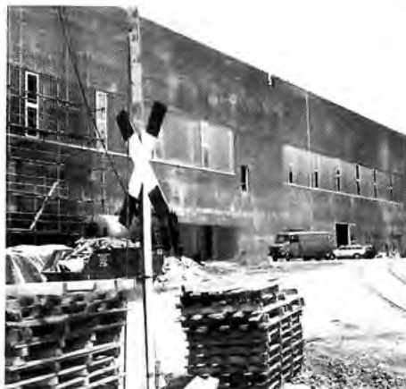
Die Südseite des Neubaus D 3.
