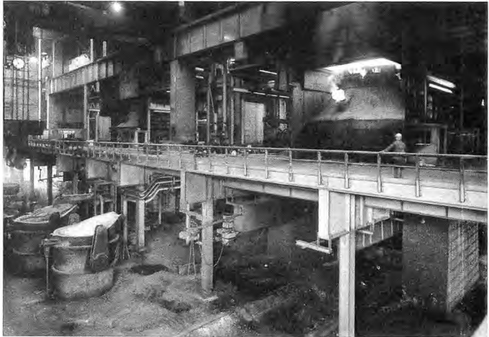
Blick in die Halle eines Oxygen-Stahlwerkes mit zwei 250-t-Konvertern. Auf dem Bild ein Konverter während des 20minütigen Sauerstoff-Blas-Vorganges.
