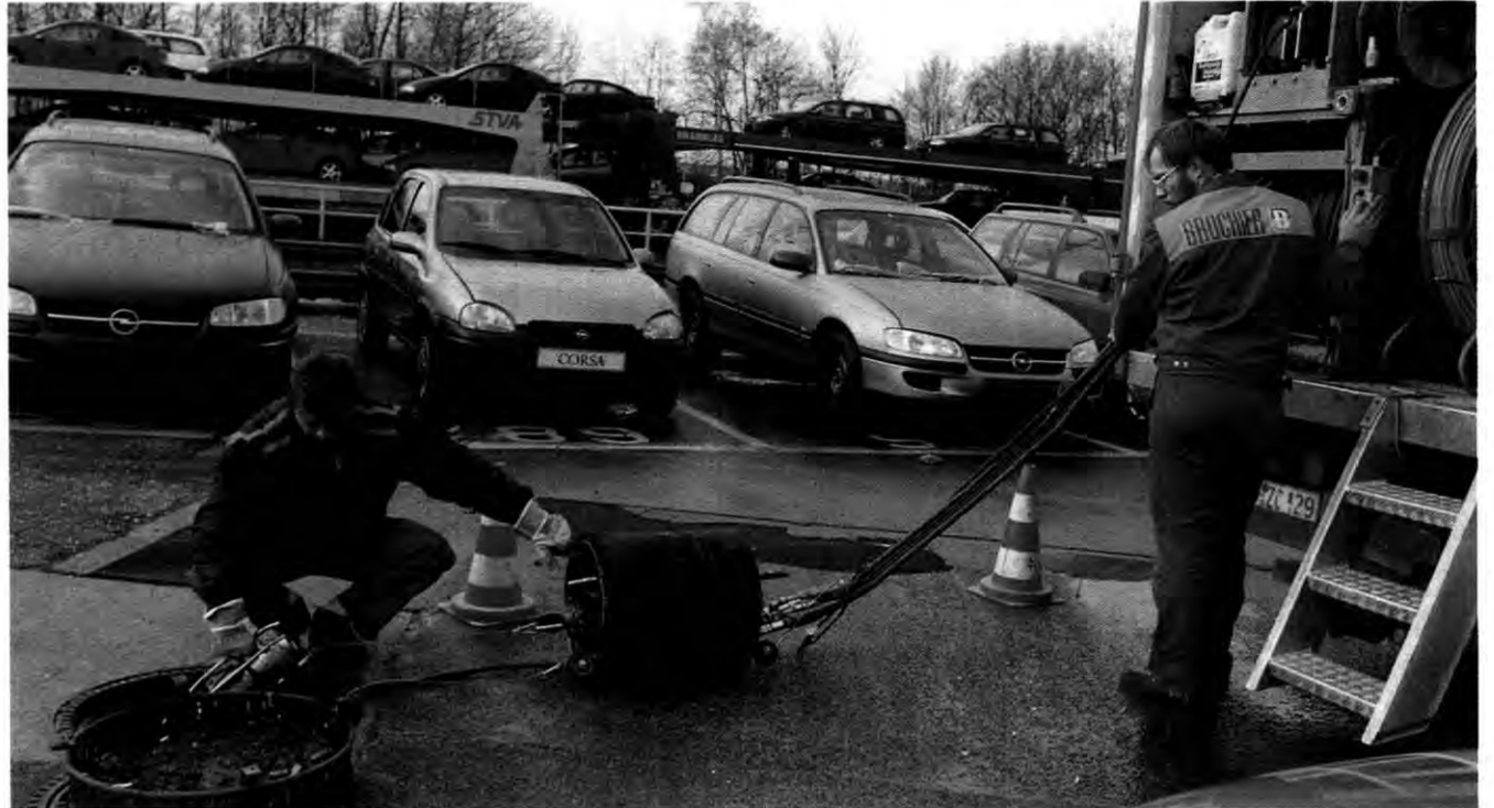
Packend: Bei Opel verschwindet nicht der Tiger im Tank, sondern der Packer im Kanal. Kameraunterstützt dichtet er Muffen ab
