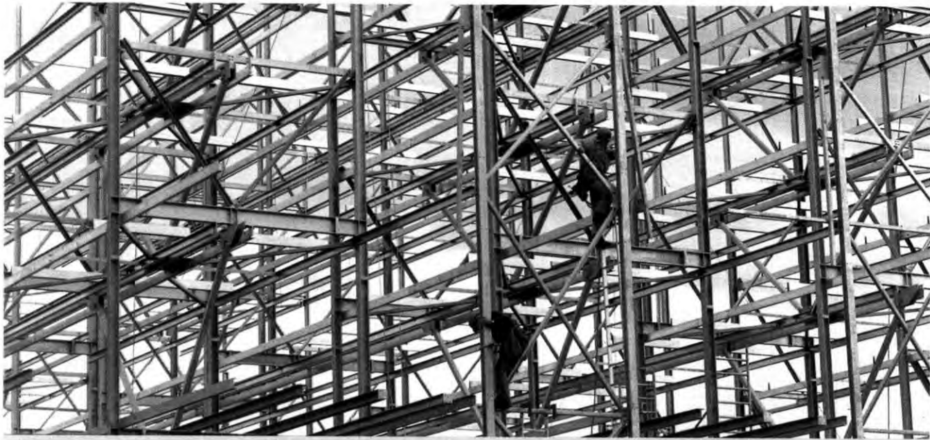
Das Karosserieverteilerzentrum im Werk Rüsselsheim nimmt imposante Ausmaße an. Nachdem die Plattform des Verteilerzentrums fertiggestellt ist und der Stahllaufbau der Regalstraßen fortschreitet, wird
