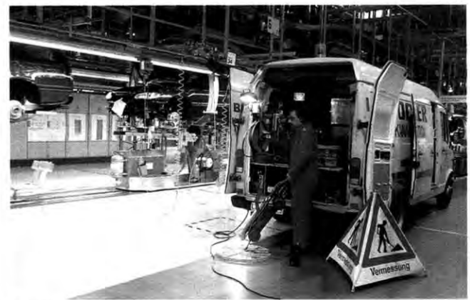
Störungsfrei: Die Produktion ist von den Arbeiten nicht betroffen
