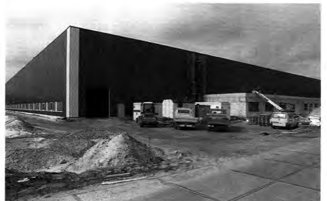
Bald geht's los: Das Warenverteilzentrum nimmt Form an
