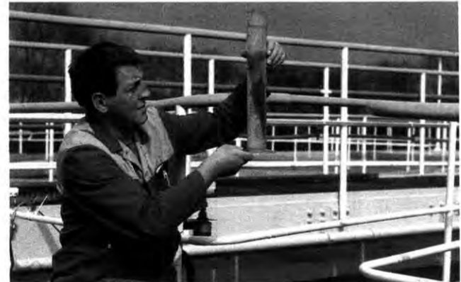
Wasser marsch: Die Überprüfung der Filteranlage gehört...
