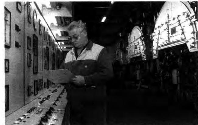
...genauso zur Service-Palette wie die Kontrolle der Kessel...
