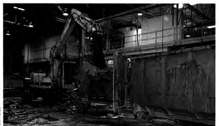
Großreinemachen: Im K 30 werden die alten Anlagen demontiert
