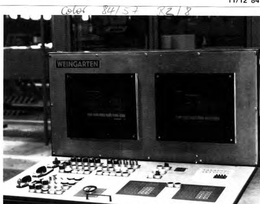
Die Monitore zeigen ständig den Betriebszustand der Presse an.
