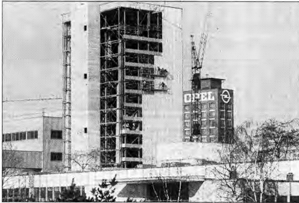
Riese: Der 42 Meter hohe Turm ist schon fast fertig
