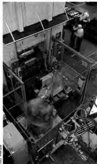
Umgestellt: Auch die letzten Pressen wurden jetzt automatisiert
